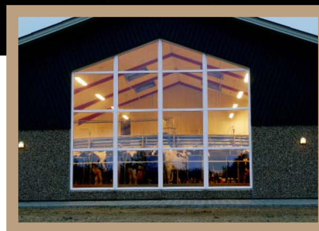
Steder som malkestald, værksted, personalerum og foderlager kan der med stor fordel monteres bevægelsessensorer eller automatisk slukning. Foto: Torben Worsøe.
